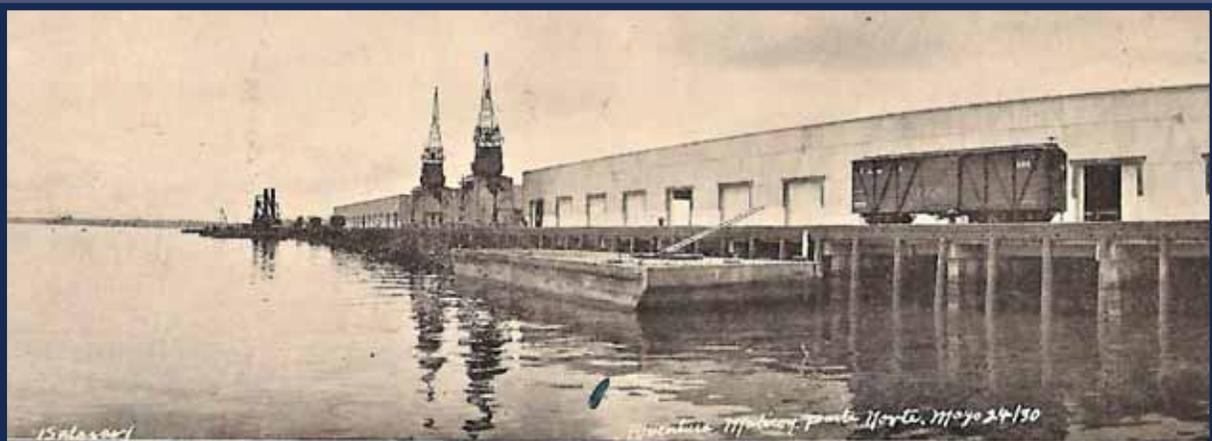
Vista del muelle con el pilotaje de defensa y dos de las grúas eléctricas de 5 toneladas.
