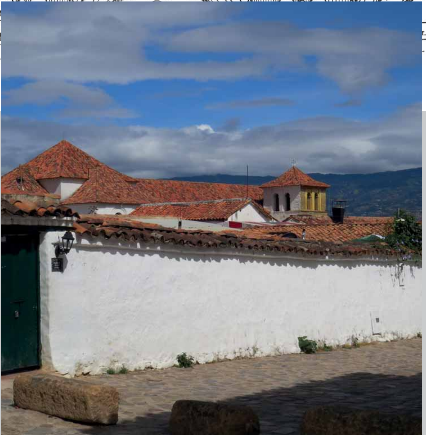
Muros de tapia son otro elemento típico de la forma de construir en ese tiempo
