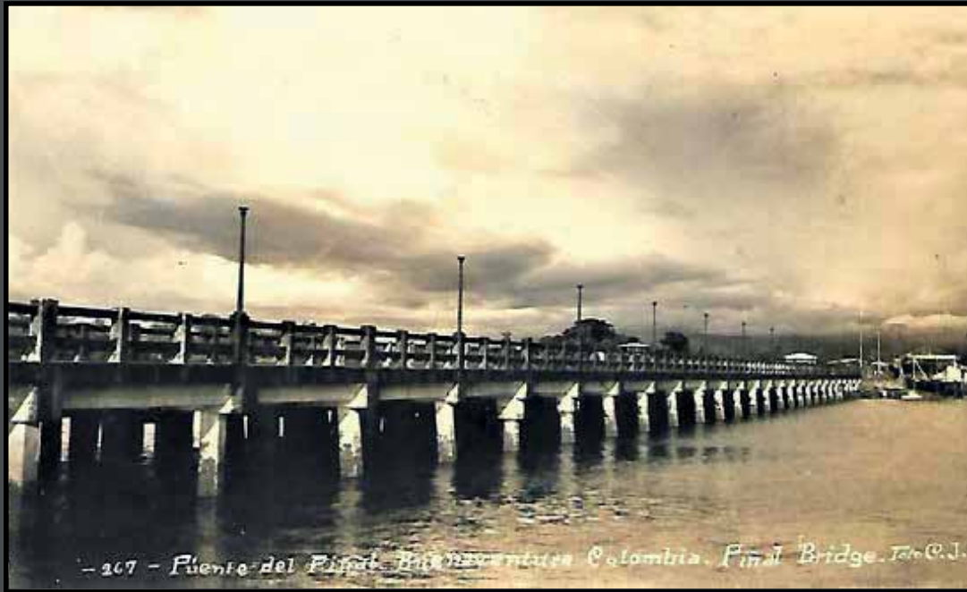
Puente El Piñal, 1958
