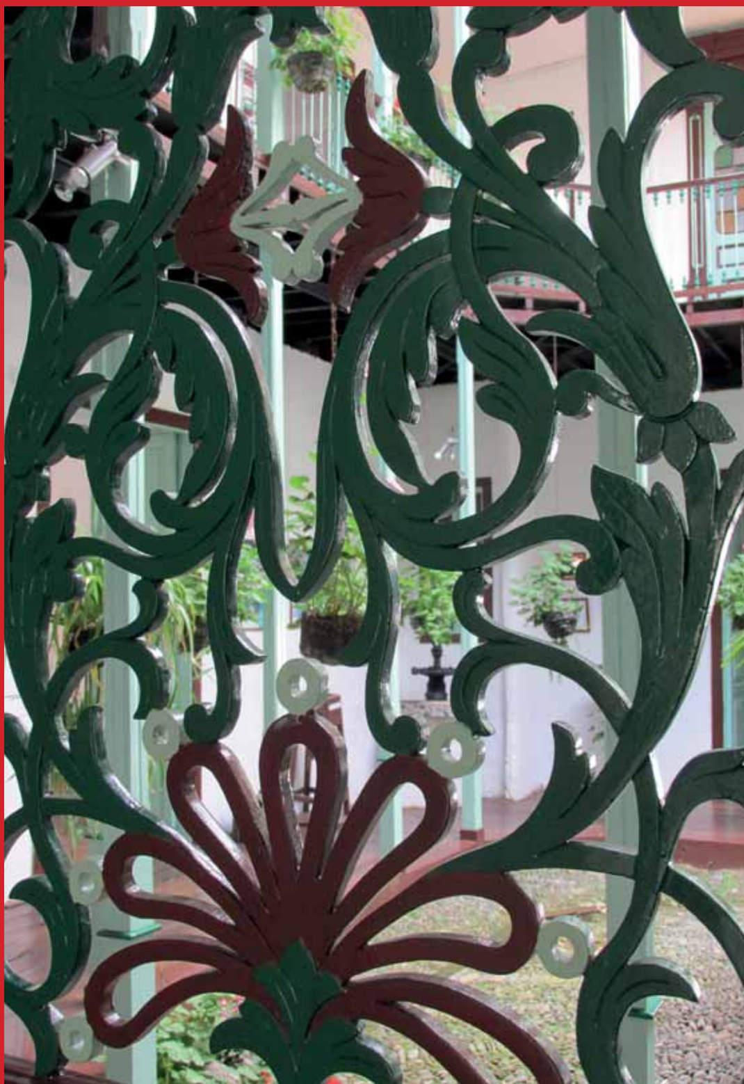
Bellos calados que servían para adornar las edificaciones, pero también como reguladores de la temperatura, Casa de la Cultura, Salamina, Caldas
