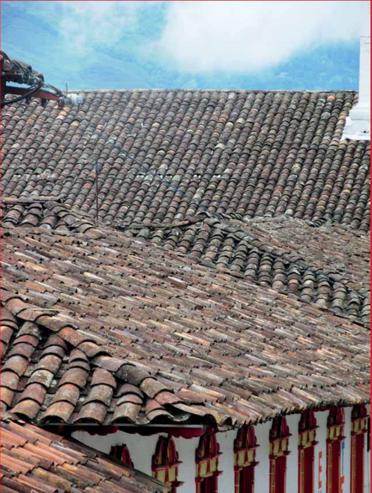
La teja, otro elemento típico del bahareque heredado de España, que a la vez lo recibió del Medio Oriente
