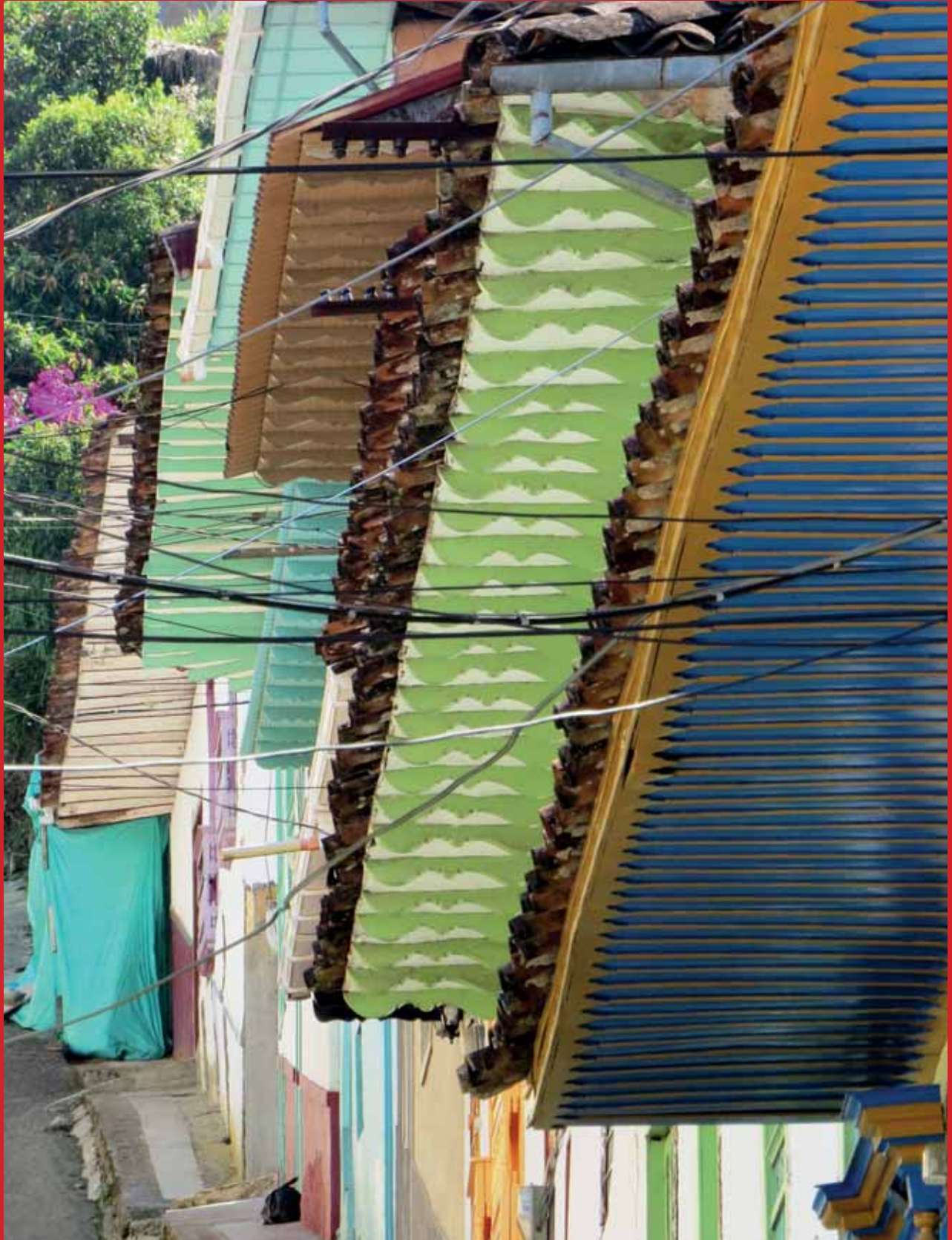
El alero es típico también, protegiendo al transeúnte como las bases del edificio de la lluvia, Aguadas, Caldas
